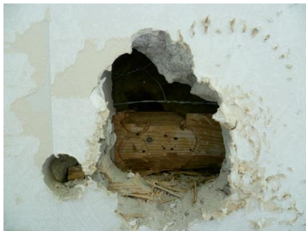
Bild 1. Lägenhet 111, vån 3, uppgång 47. Materialprov tagna från tryckimpregnerade träreglar i väggarna.
