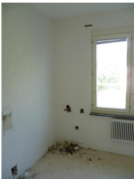
Bild 1. Lägenhet 111, vån 3, uppgång 47. Materialprov tagna från tryckimpregnerade träreglar i väggarna.
