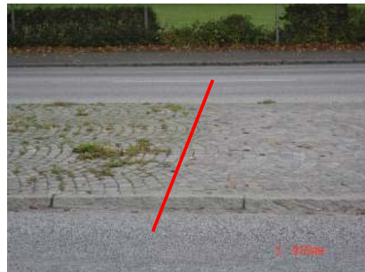
Bilden visar en täckningsgrad på 2 % till höger om den röda linjen och 8 % till vänster om linjen.
